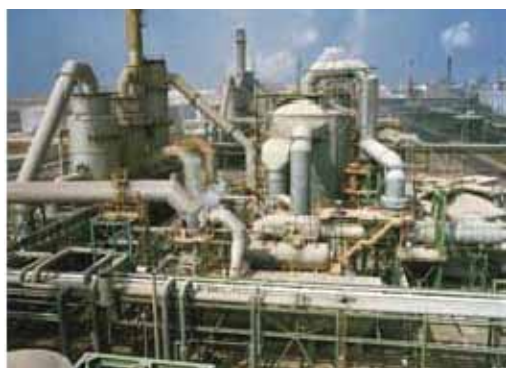
Figura 6 – Presencia de polvo
